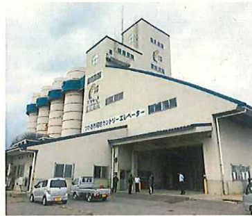
カントリーエレベーター
